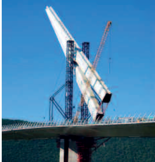
Het plaatsen van de pylonen voor de hoogste brug ter wereld nabij het Zuidfranse Millau
