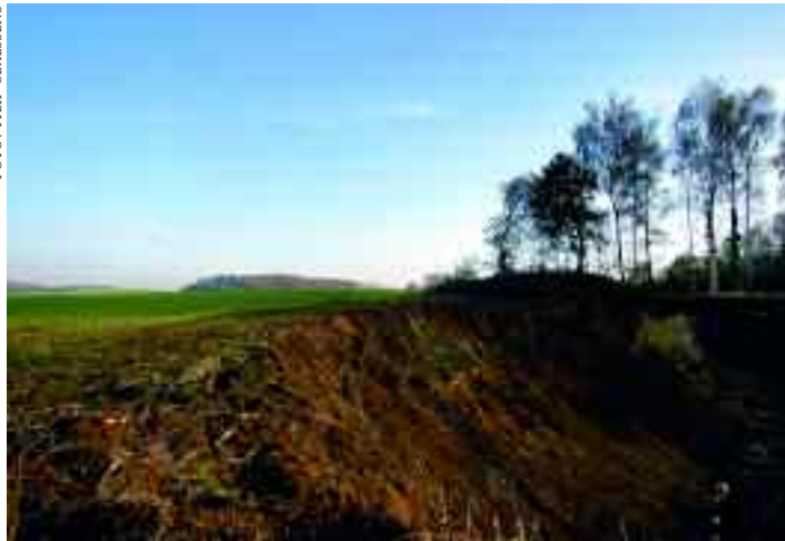
Na 13 jaar zijn in de Flosstraat in Vossem de voorbereidende werken gestart voor de bouw van een rioolwaterzuiveringsinstallatie
