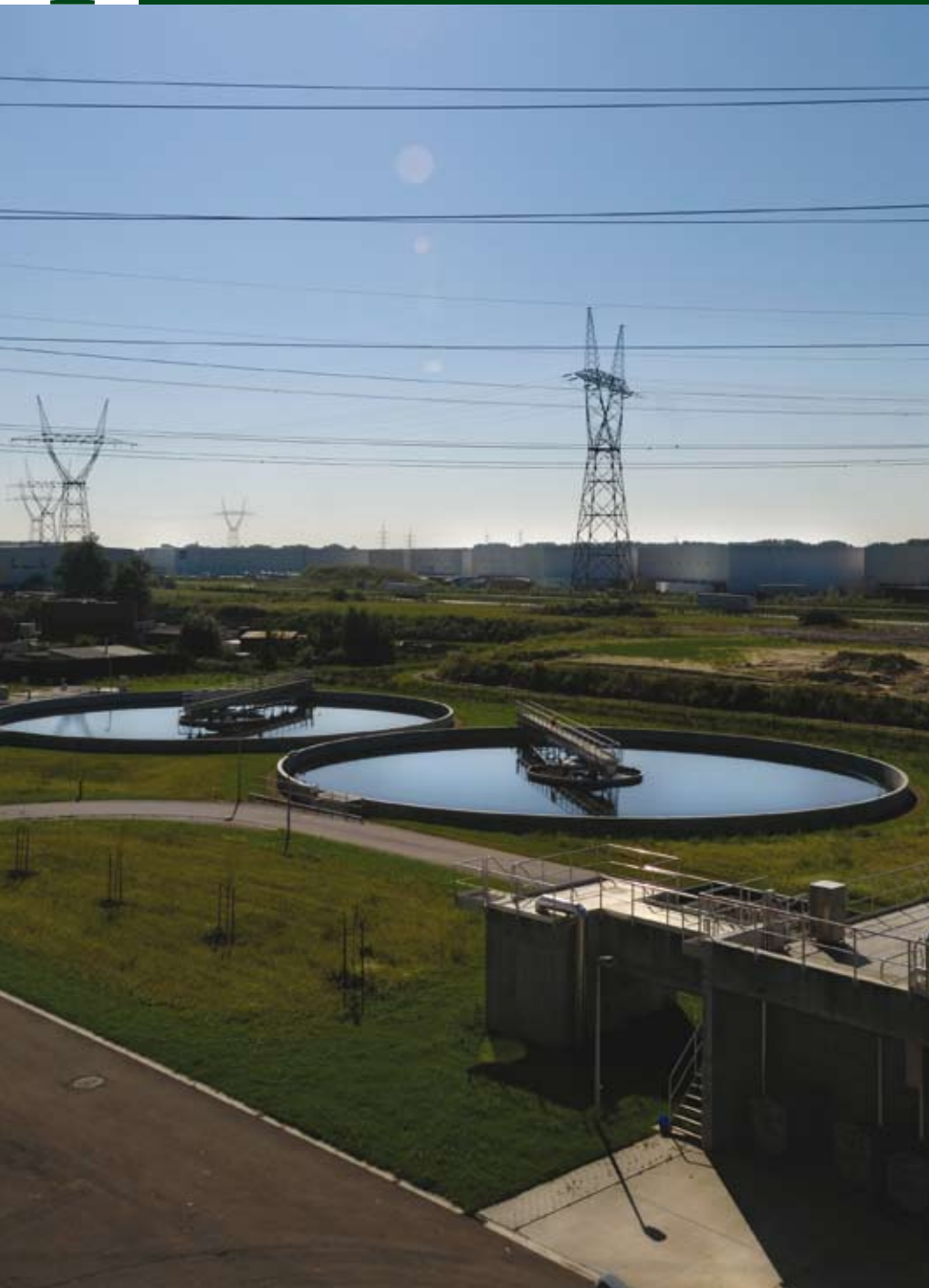
Het waterzuiveringsstation aan de Verbrande Brug in Grimbergen
